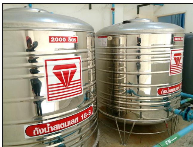
ภาพที่ 1-4 ถังเก็บน้ำสำรองของโครงการฯ
