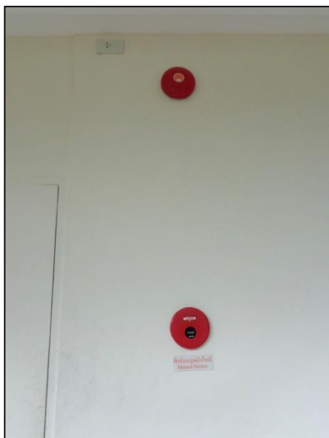
ภาพที่ 1-13 อุปกรณ์แจ้งเหตุเพลิงไหม้แบบมือกด และอุปกรณ์ส่งสัญญาณชนิดกระดิ่ง
